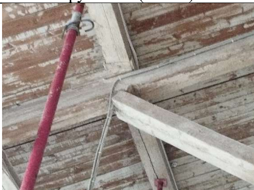
Смещение опорного подкоса из опорного узла (врубки) верхнего пояса фермы покрытия.
