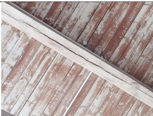
Продольные трещины в элементах прогонов покрытия.
