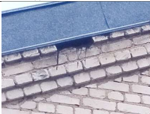
Участки разрушения кирпичной кладки в верхней части карниза наружной стены здания в осях 1/А-Б вследствие разморозки.
