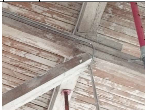
Смещение опорного подкоса из опорного узла (врубки) верхнего пояса фермы покрытия.
