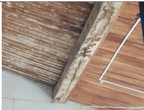
Продольные трещины в элементах прогонов покрытия.
