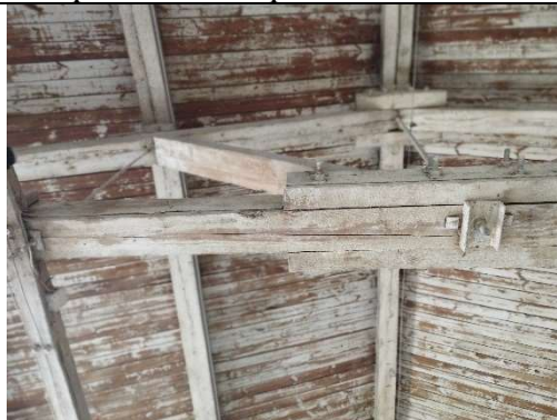
Продольные трещины в элементах ферм покрытия.
