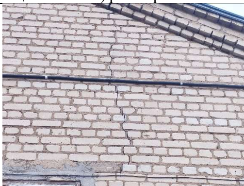
Вертикальные трещины в наружной стене здания в осях 1/А-Б.
