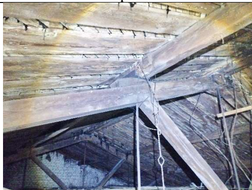
Участки загнивания деревянных элементов покрытия.
