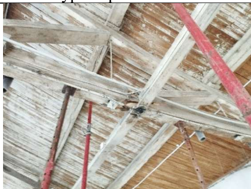
Разрушение (излом) нижнего пояса фермы покрытия в осях 5/А-Б.
