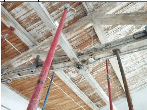
Разрушение (излом) нижнего пояса фермы покрытия в осях 5/А-Б.
