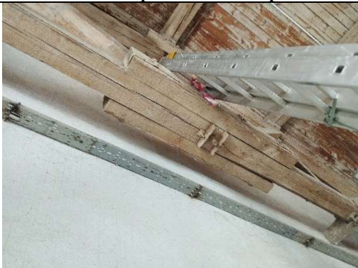
Продольные трещины в элементах ферм покрытия.
