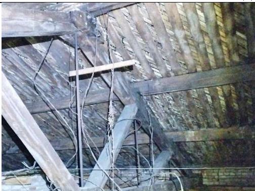
Участки загнивания деревянных элементов покрытия.
