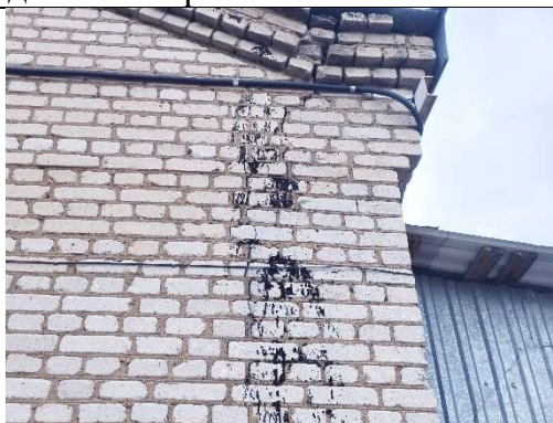
Вертикальные трещины в наружной стене здания в осях 1/А-Б.
