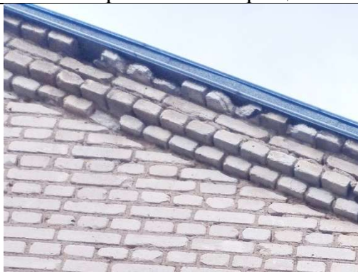
Участки разрушения кирпичной кладки в верхней части карниза наружной стены здания в осях 1/А-Б вследствие разморозки.
