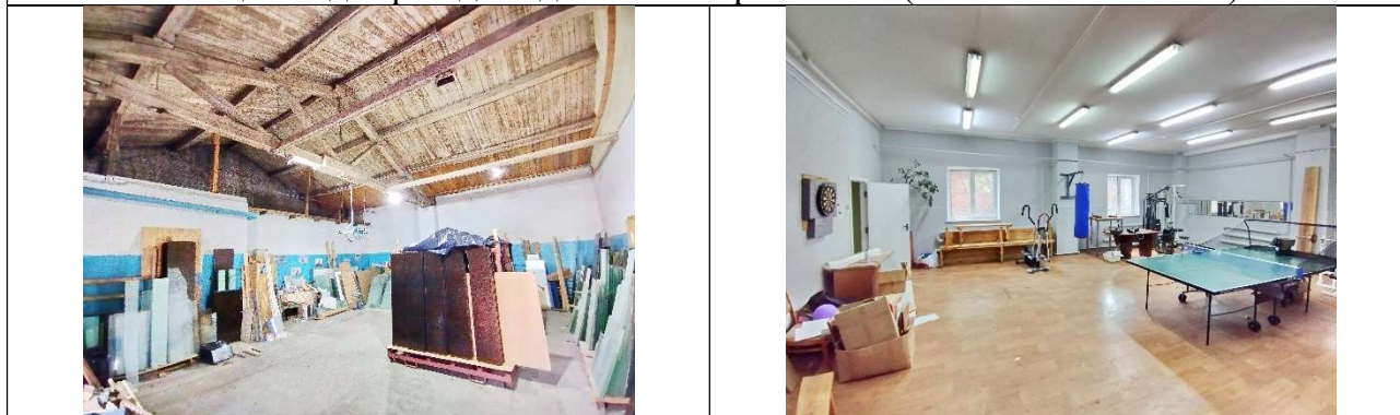
Общие виды помещений внутри здания мастерских №2 (инв. №500/С-16706).
