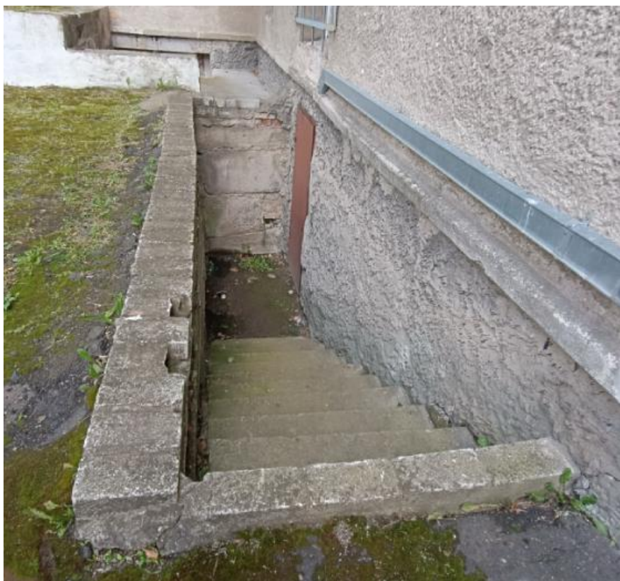
Фото 2.1.2. Наружный приямок входа в подземный этаж в осях «5-2»
