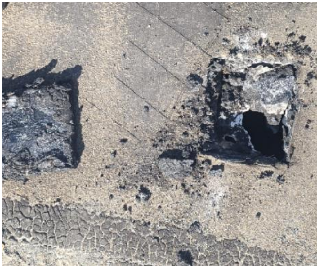
Фото 2.5.3. Вскрытие кровли Вкр1
