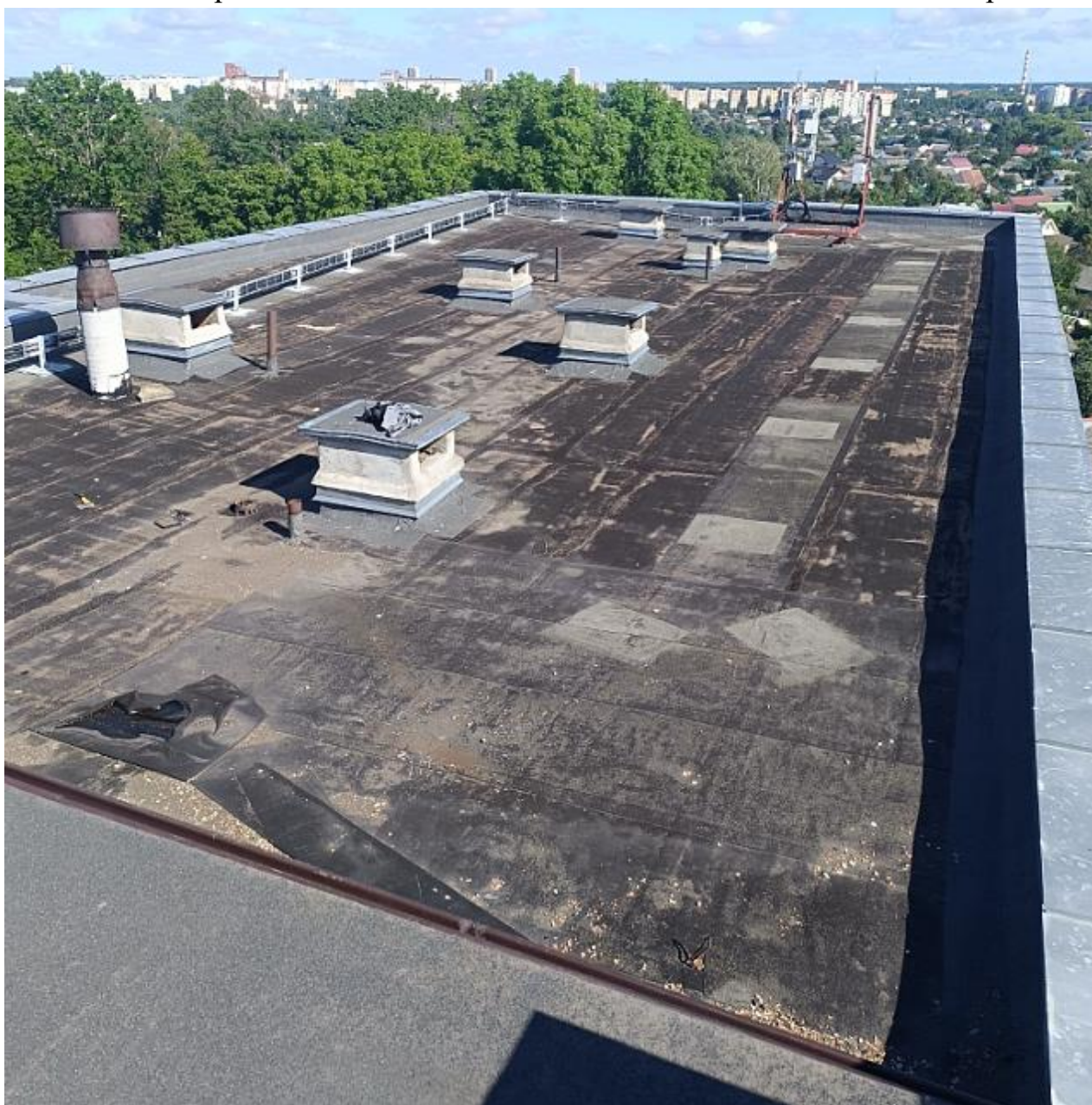
Фото 2.5.1. Общий вид кровли
