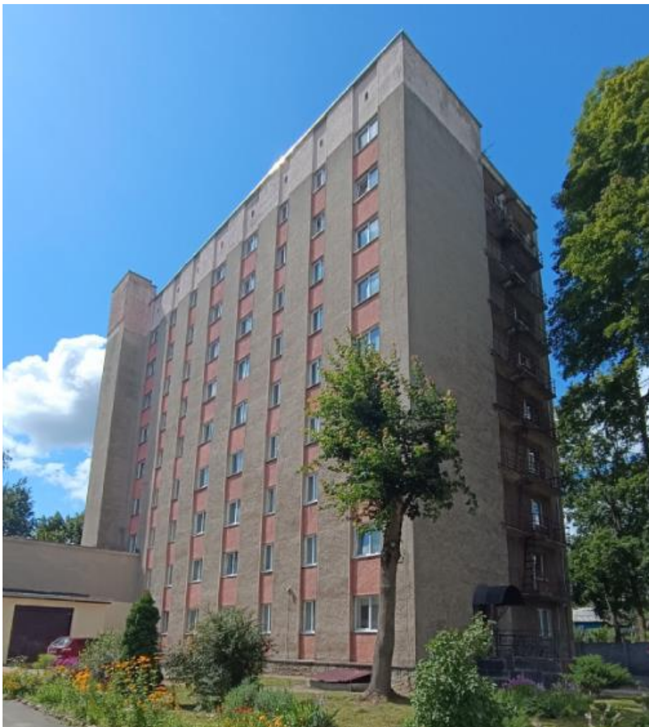
Фото 1.3 Фасады здания в осях «Г-К» и «12-5»
