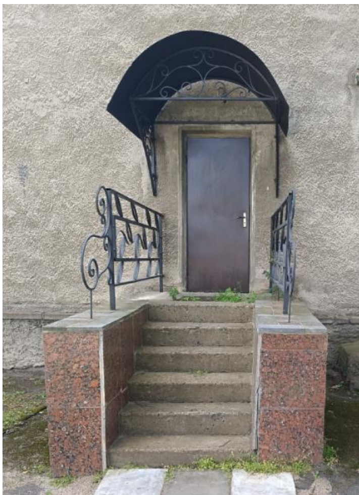
Фото 2.10.2. Вход со двора осях «11-10» (общий вид)
