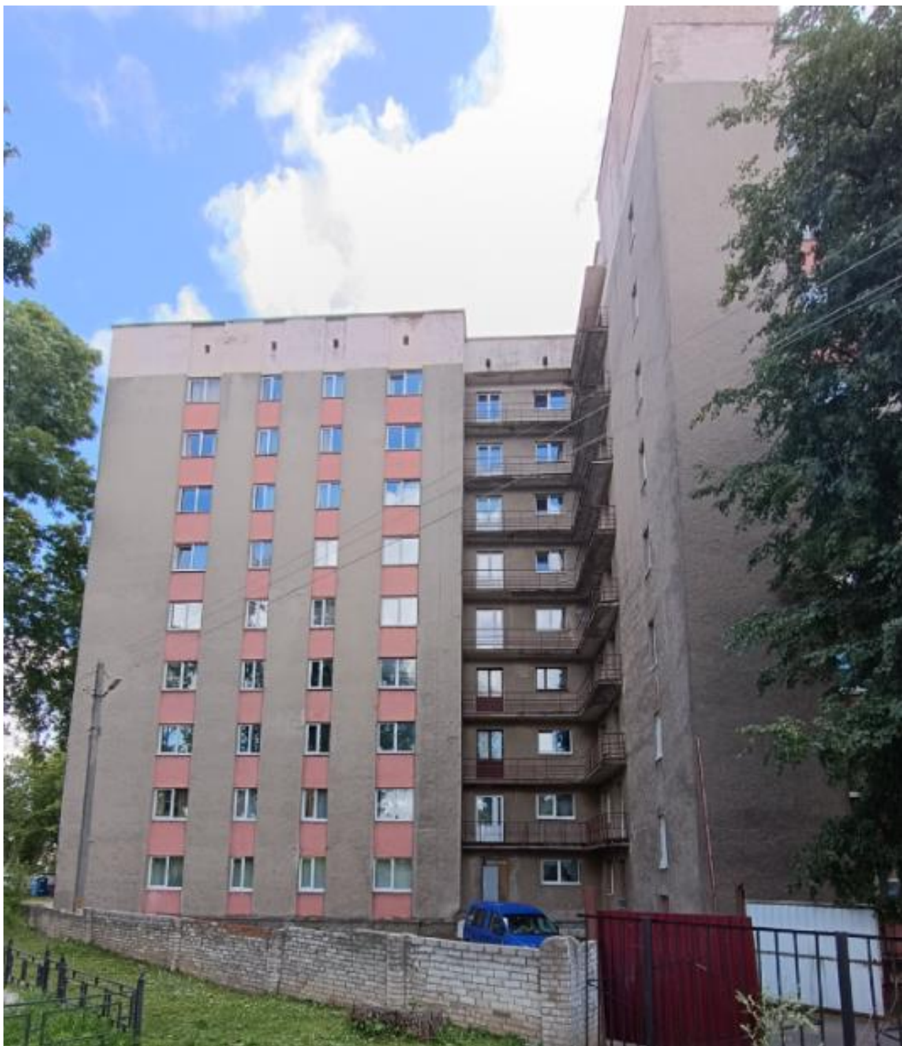
Фото 1.4 Фасады здания в осях «И-Е» и «Б-1»
