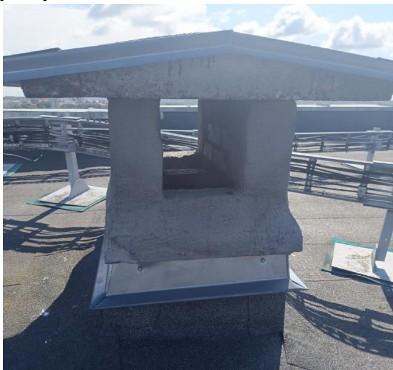
Фото 2.6.1. Общий вид вентшахт
