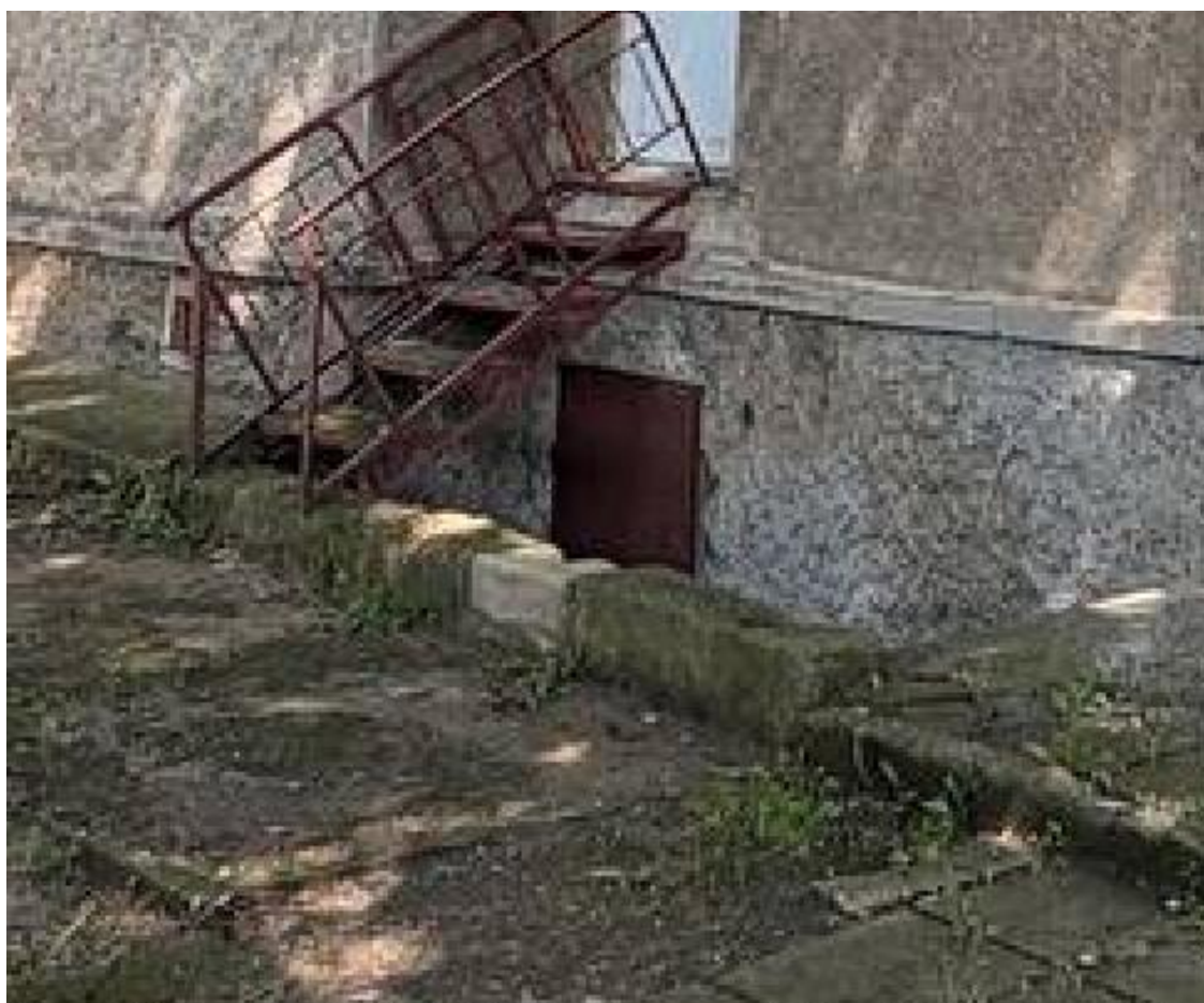
Фото 2.1.1. Наружный прямок входа в подземный этаж в осях «3-8»
