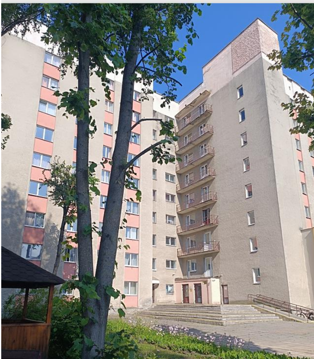
Фото 1.1 Главные фасады здания в осях «7-12», «А-Г»
