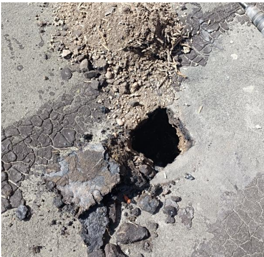
Фото 2.11.3. Вскрытие кровли Вкр3
