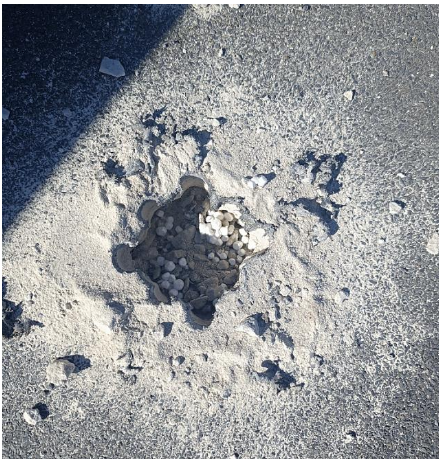
Фото 2.5.4. Вскрытие кровли Вкр2
