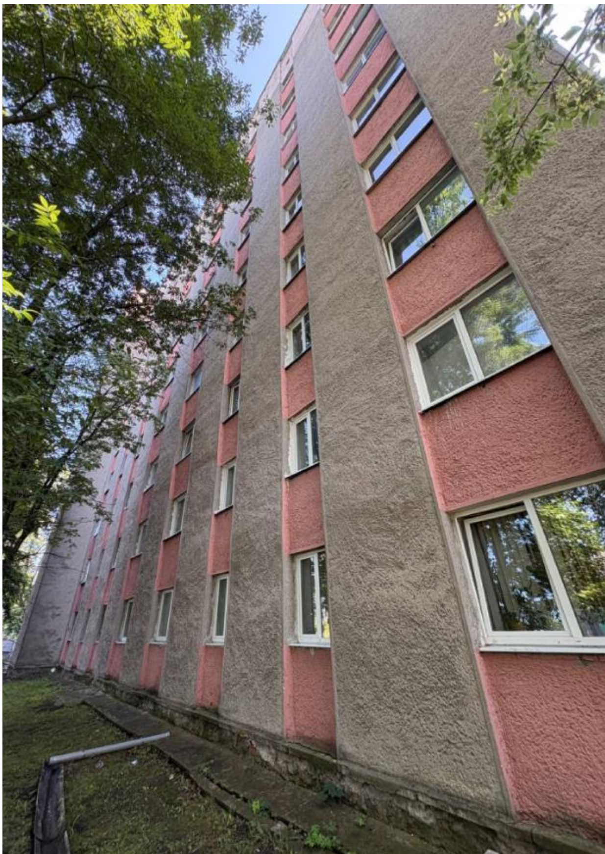
Фото 1.5 Фасад здания в осях «Д-А»
