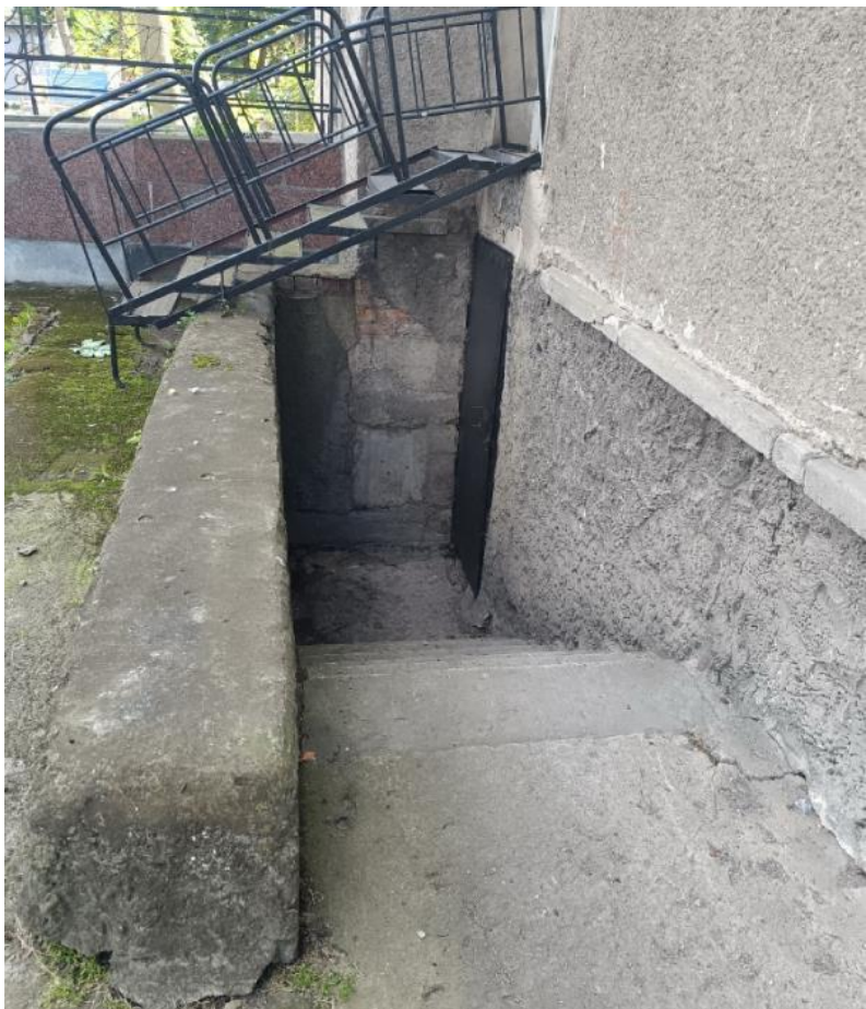
Фото 2.1.3. Наружный приямок входа в подземный этаж в осях «10-5»
