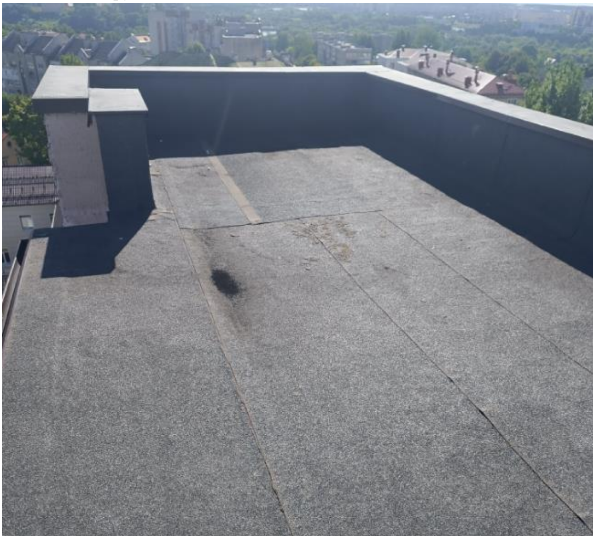
Фото 2.5.2. Общий вид кровли надстройки
