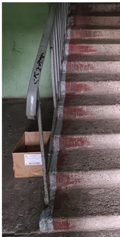
Рис. 12. Отсутствуют ламели ограждения марша
