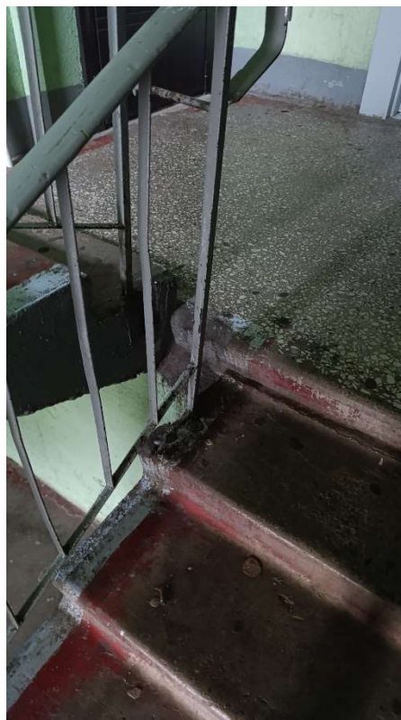
Рис. 12. Отсутствуют ламели ограждения марша
