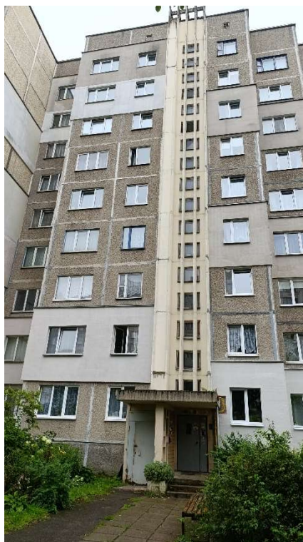
Рис. 1. Общий вид входной группы (секция 2)
