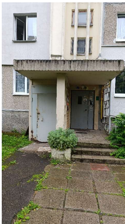
Рис. 2. Общий вид входной группы (секция 2)
