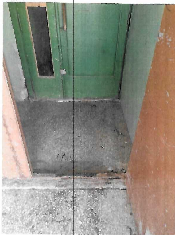
Фото 6. Порог наружного и тамбурного блока
